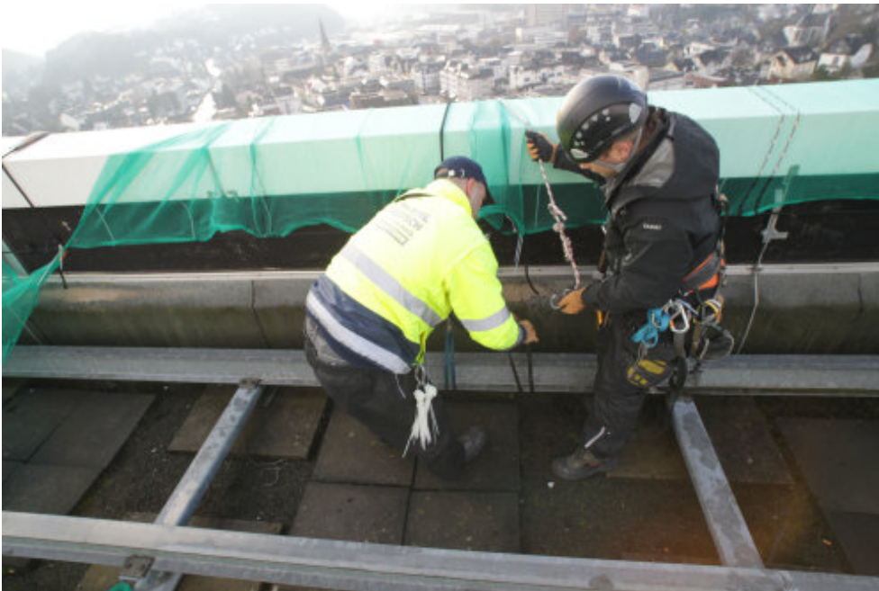
Auf dieser Stahlkonstruktion sollen die technischen Geräte zum Abhörschutz standsicher montiert werden (Foto:OBK) Link auf Original-Bild
