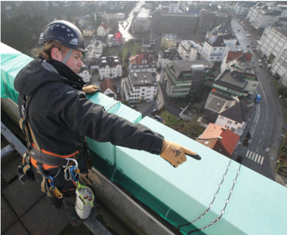
An der Attika des Kreishausdaches wird ein Vlies befestigt: Vorarbeiten für die Installation modernster Abhörschutz-Technik.(Foto:OBK) Link auf Original-Bild
